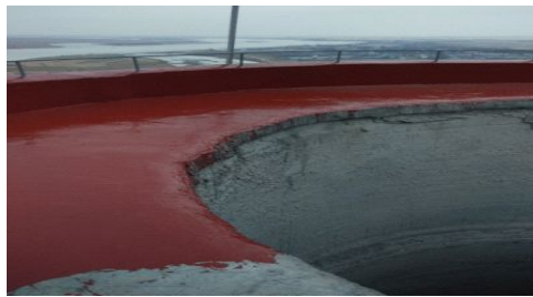
图 5：新型防冰装置（内倾 35°）
