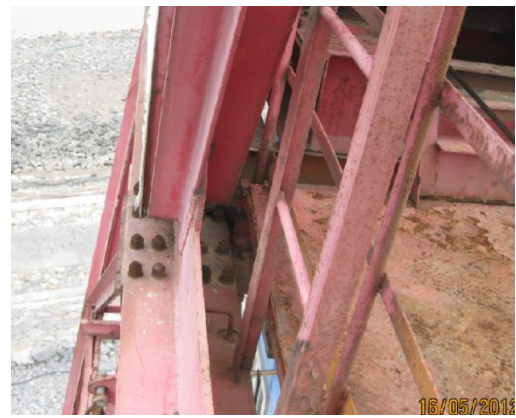
图 1.8 刚性支腿与主梁螺栓连接图
