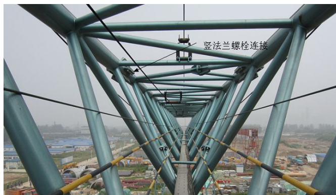
图 2.1 法兰连接主梁结构
